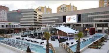
Alış Veriş Merkezi-İstanbul/Kayaşehir
