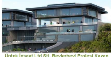
Üntek İnşaat Ltd.Şti. Beylerbeyi Projesi Kazan Bacası-İstanbul-Beylerbeyi
