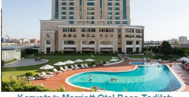
Kozyatağı Marriott Otel Baca Tadilatı- İstanbul-Kozyatağı
