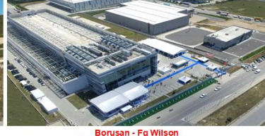
Borusan - Fg Wilson Turkcell Data Merkezi 5. Etap Dizel Jeneratör Bacaları-Kocaeli-Gebze
