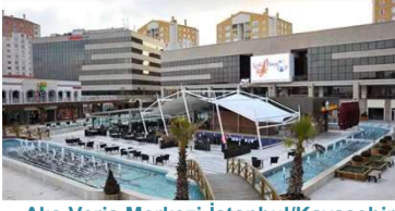
Aliş Veriş Merkezi-İstanbul/Kayaşehir
