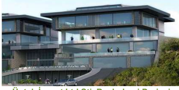
Üntek İnşaat Ltd.Şti. Beylerbeyi Projesi Kazan Bacası-Istanbul-Beylerbeyi
